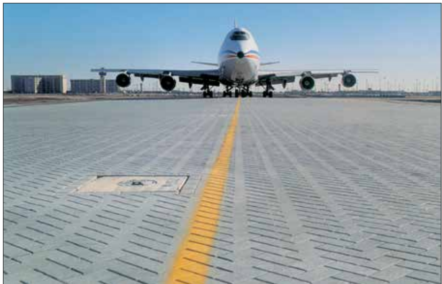
Figur 2.6. Betonsten er meget velegnet til at optage store hjultryk fra eksempelvis fly som kan have et hjultryk på op til 40 ton.
