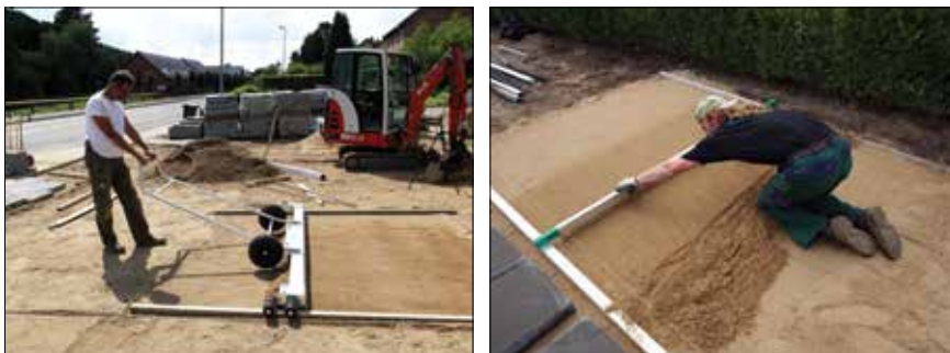
Figur 3.22. Udstyr til afretning. Afretningen kan også blot foretages med et lige bræt og ledeskinner i form af jernrør der lægges i afretningslaget.
