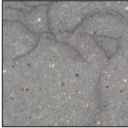
Figur 2.51. Eksempel på alkaliselreaktioner, også kaldet "spindelvæv".
