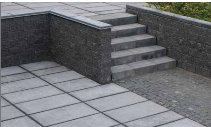
Figur 2.21. Der findes mange forskellige typer støttemursblokke, her er benyttet en enkel blok med rustik overflade. Til trappen er der benyttet betonblokke.
