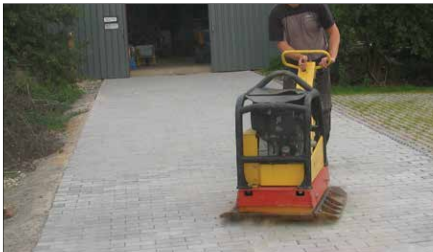
Figur 3.37. Det benyttes en stor pladevibrator på min. 180 kg til vibrering.
