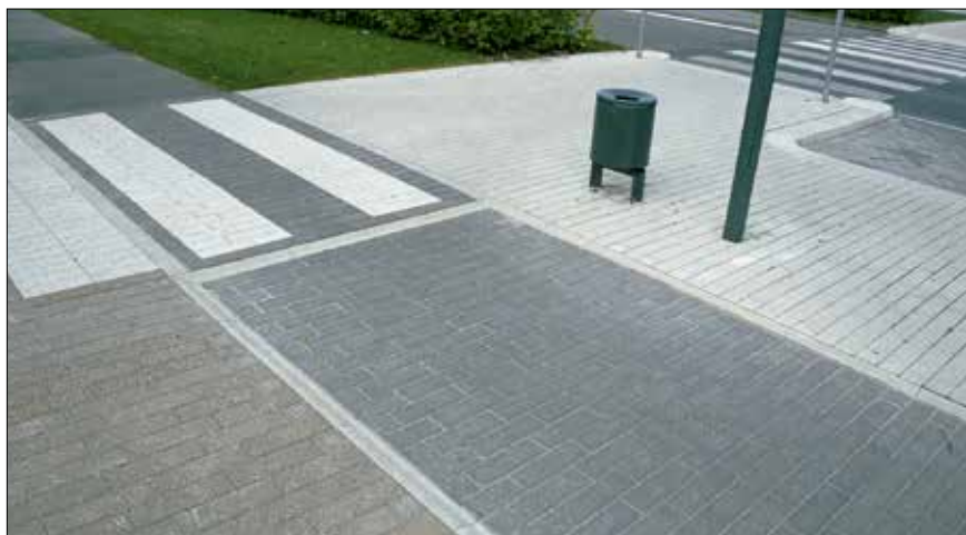
Figur 2.2. Adskillelse af biler, cyklister og gående kan ske smukt og effektivt med betonsten i forskellige farver og varierende overflader. (Allerød).
