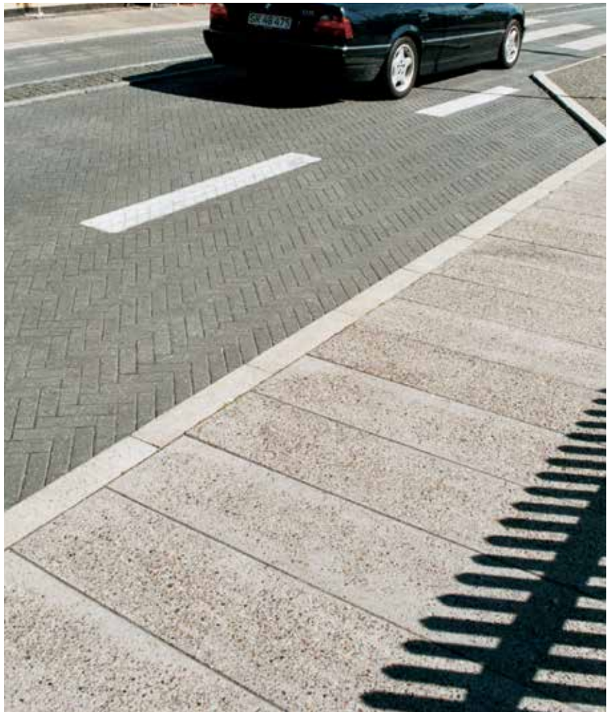
Figur 2.2. Eksempel på brugen af betonsten og specialfliser i en bymidte. (Skagen)
