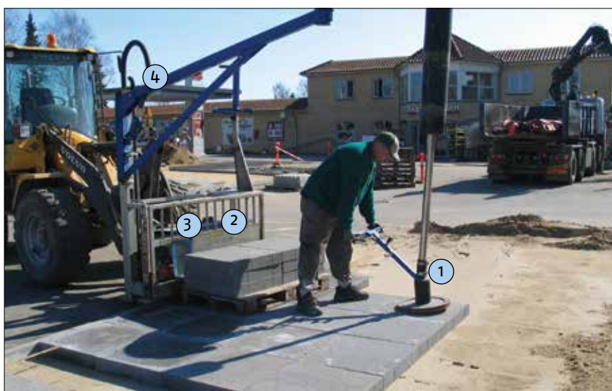
Figur 3.68. Vakuumløfteudstyret har flere dele der skal være fokus på: 1. Pakning ved mundstykke. 2. Luftfilter ved pumpe/turbine. 3. Pumpe/turbine (mhp. slidtage). 4. Utætheder ved samlinger.
