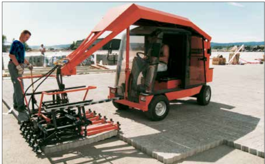
Figur 3.27. Maskinnedlægning af betonsten – hurtigt og effektivt.
