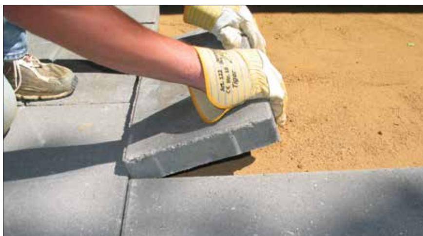
Figur 3.41. Fliserne lader man som betonsten, skride skråt ned for at opnå den korrekte fugebredde.
