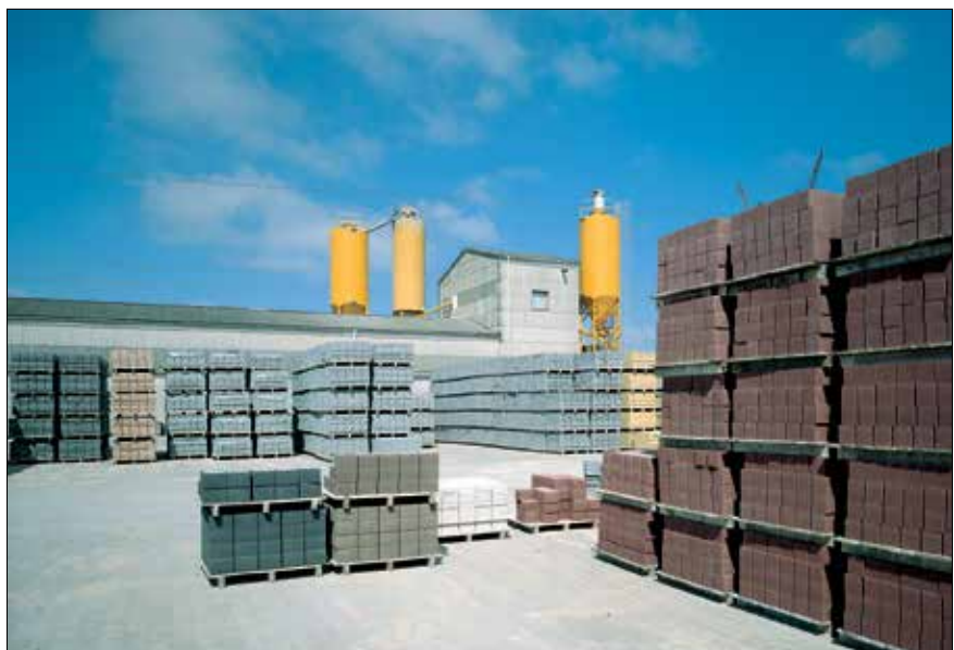
Figur 2.37. Mindre betonstensfabrik. I forgrunden ses en del af lageret og i baggrunden ses produktionshal og cementsiloer.
