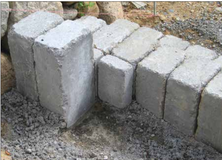
Figur 3.51. Sætning af trappe i jordfugtig beton.
