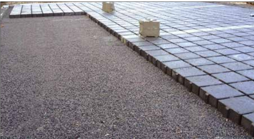
Figur 3.78. Udlægning af sten på permeabelt underlag. Bemærk det grove afretningsmateriale.
