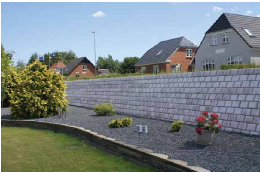
Figur 2.22. Eksempel på én type støttemursblok. Jo større hældning muren sættes med, jo højere kan muren laves, uden risiko for væltning/udtrykning.
