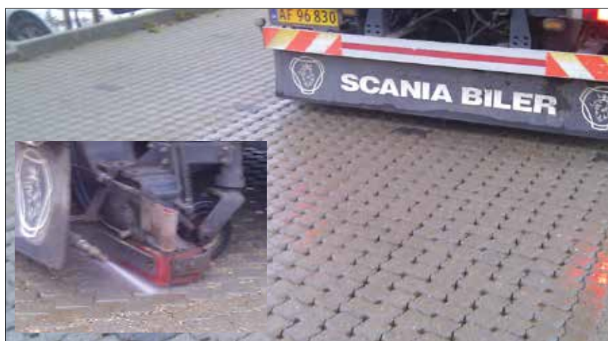
Figur 3.79. Oprensning af fuger, med specialkøretøj der spuler og suger.
