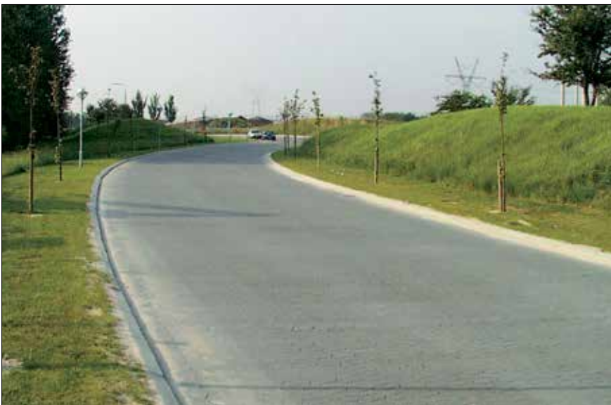
Figur 2.1. Betonsten og -fliser er også meget velegnede til almindelige veje. Her en nyanlagt adgangsvej til en industrivirksomhed.
