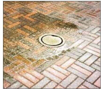
Lunker, der giver vandsamlinger, skal rettes.
